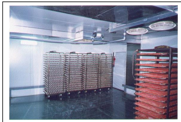
Interior de cámara para 40 carros
