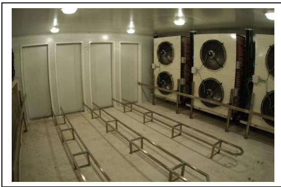
Interior de túnel para 1.000/1.100 kg/h Diseño adaptado a las dimensiones del local. 1 puerta de entrada y cuatro de salida
