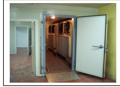
Túnel de 400/450 kg/h 2 equipos de doble etapa de 25 CV cada uno
